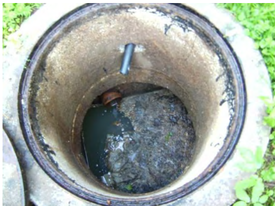
Beispielbild: „Erste Kammer Zulauf“
